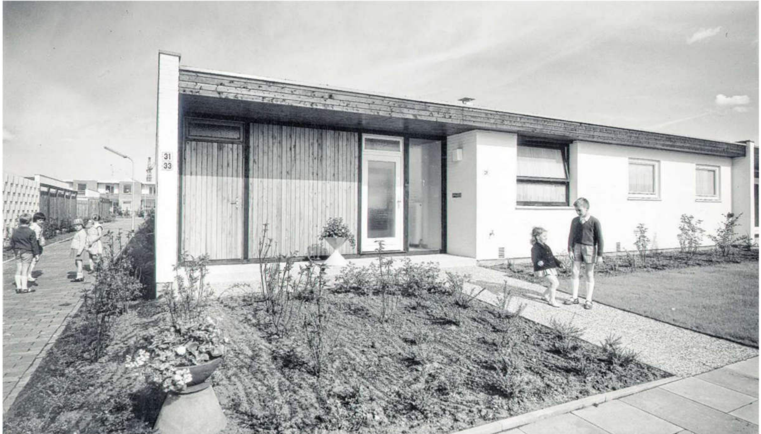
Ein Gartenhofhaus im Quartier Blockdiek: Links neben der Eingangstür befindet sich der sogenannte Hochkeller.
