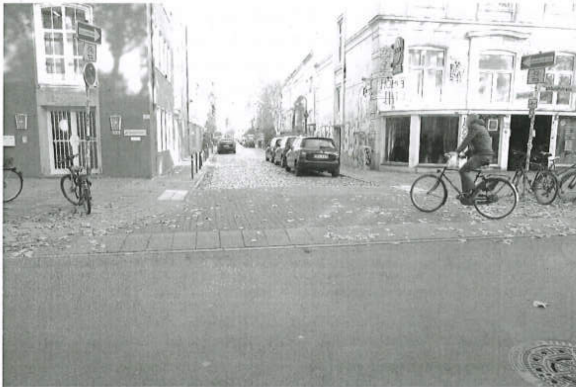
Abbildung 3 Teilaufpflasterung in der Humboldtstraße, Bremen
