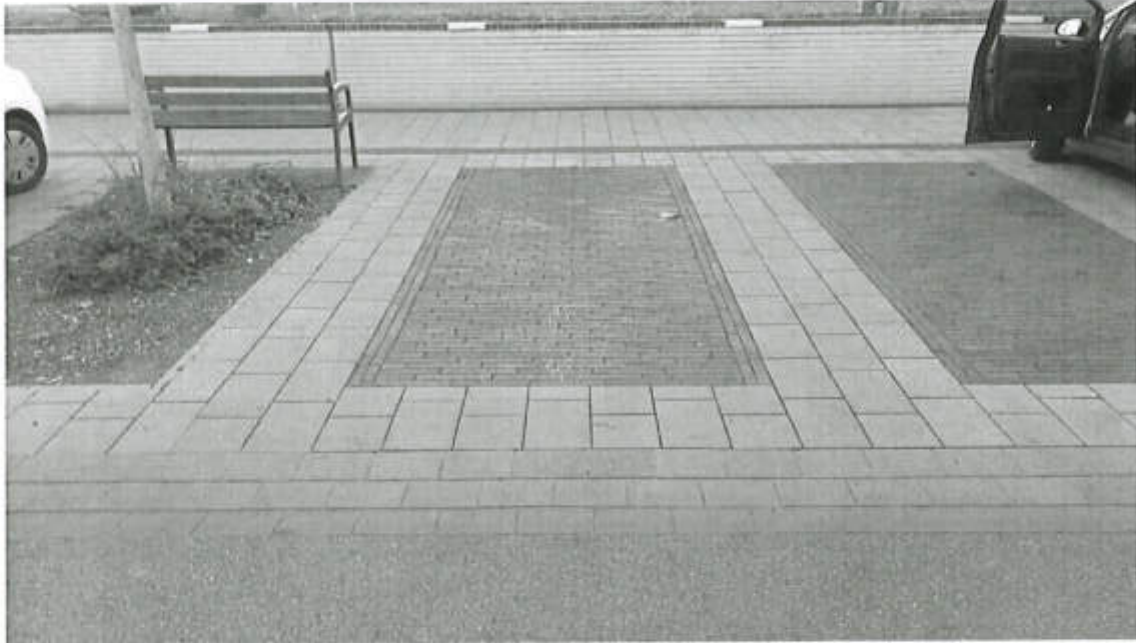
Abbildung 6 Beispiel Parkbucht (Reeperbahn in Verden)
