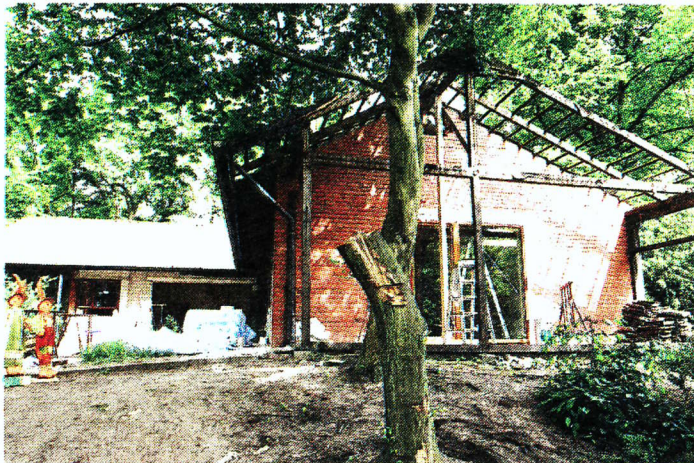
Vor einigen Monaten noch eine Baustelle, doch inzwischen ist das Gebäude für die Hauswirtschaftler nahezu fertiggestellt.
